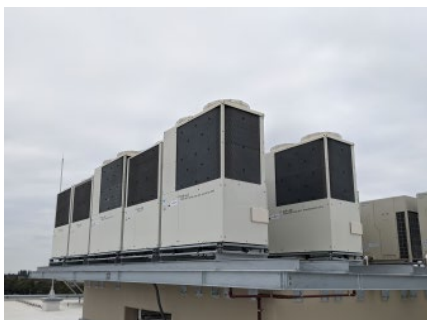
外国語・学術情報メディアセンター個別方式空調機の設置
