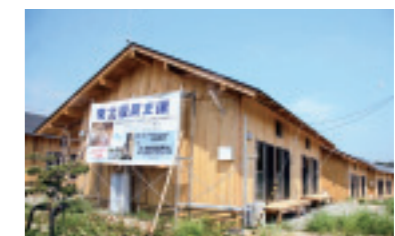
本学教員設計の仮設住宅（いわき市）
