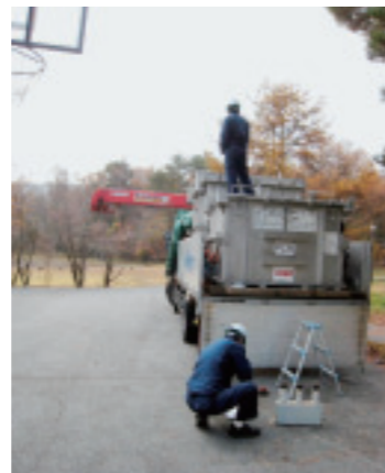
山中共同研修所・高圧コンデンサ搬出作業
