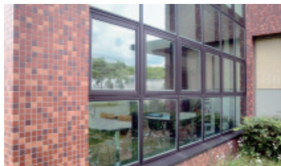
遺伝子実験センターの窓の遮熱フィルム貼り
