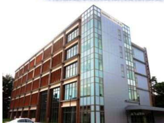
国際産学連携本部が設置されている高細精医療イノベーション棟
