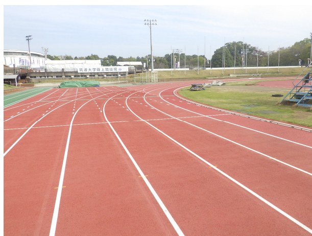
【南地区】 陸上競技場改修工事
