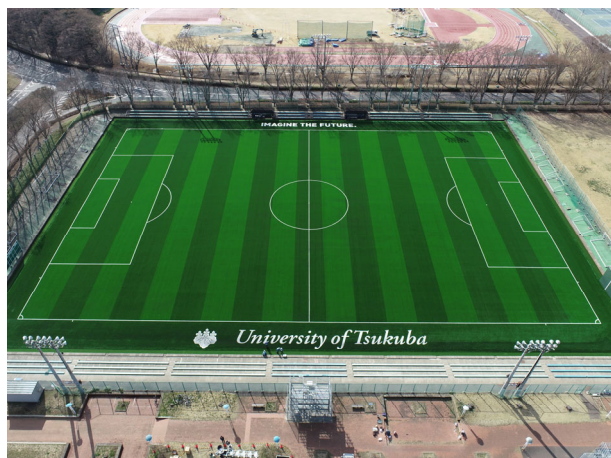
【南地区】 第1 サッカー場改修工事
