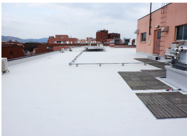
【中地区】 3C・D棟屋上防水改修工事
