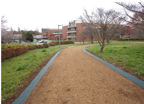
【中地区】 虹の広場ランニングロード改修工事
