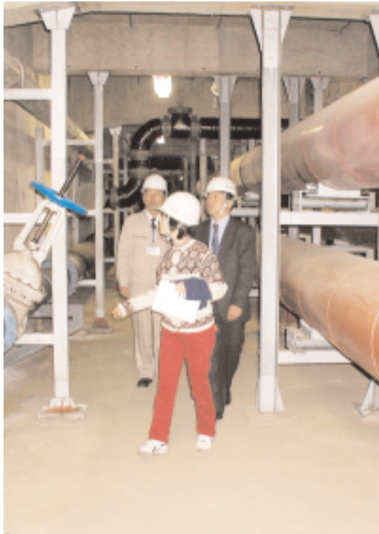
暖房使用期間中、右側の配管には高温水が流れる
