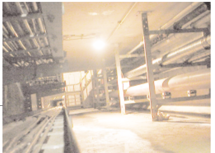
各種配管、ケーブルが整然と並んでいる共同溝内
