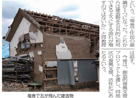
竜巻で瓦が飛んだ建造物
