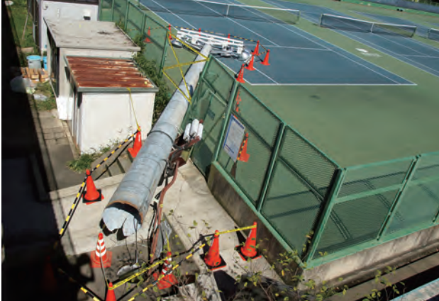
根元が破断し、倒壊したテニスコートの照明(10月13日、体芸テニスコートで)
