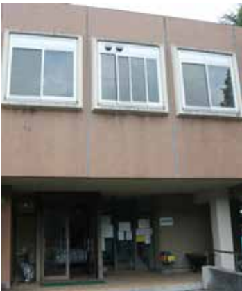
解体される体育合宿所(10月10日、つくば市天久保で) =川上真生撮影
