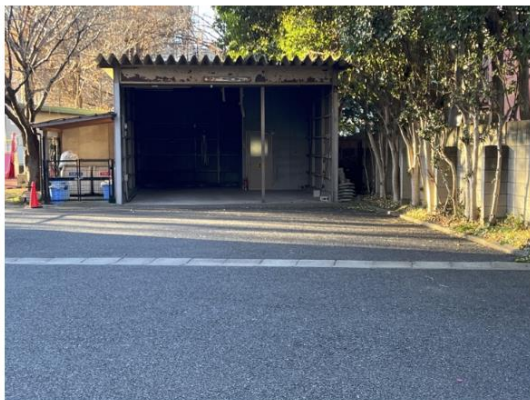
【1/29 改修前のガレージ】
