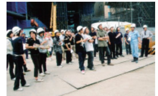
汐留シオサイト工事現場見学
