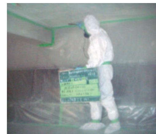
アスベスト除去作業
