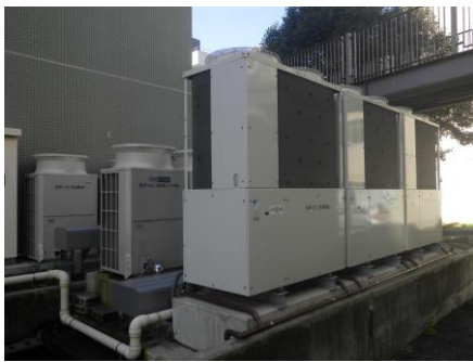
(中地区) 1A棟に個別方式空調機の設置
