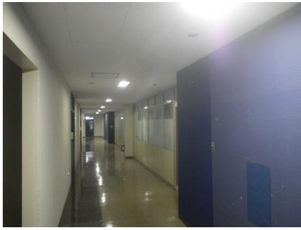
工学系学系F棟照明改修によるLED照明の設置
