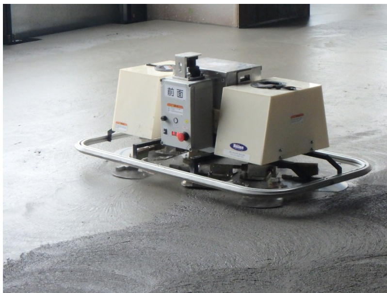
写真1 コンクリート床仕上げロボット作業状況
